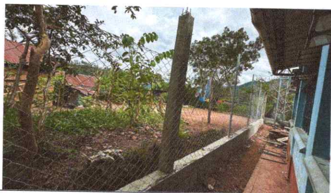
Foto 3: Ahora si la escuela tiene la circulación completa con muro perimetral
