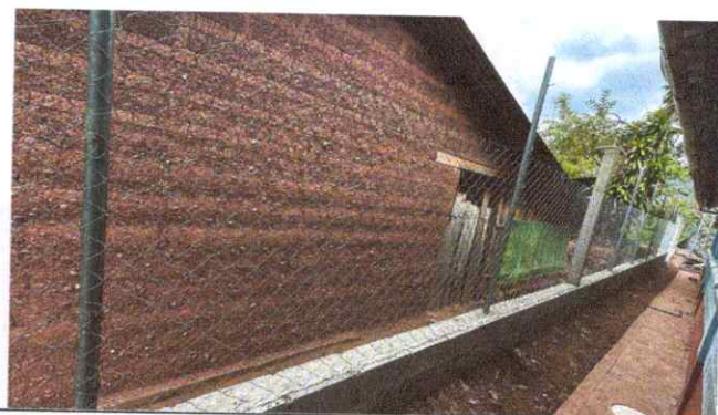
Foto 2: cimiento, hiladas de block, tubos y malla conforman el muro perimetral
