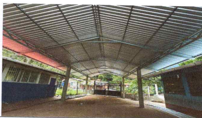
Foto 4: sustitucion de soporte de metal y lámina.
