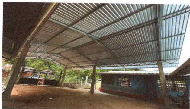
Foto 5: techo terminado completamente
