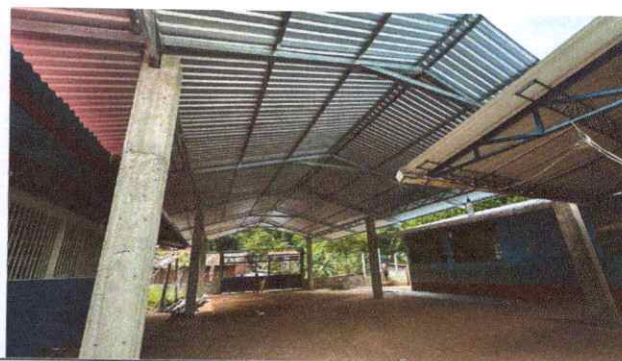
Foto 6: Finalización del techo.
