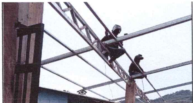
Foto 6: finalizando el armado de la estructura de soporte para el techo
