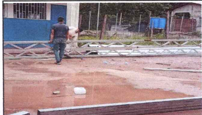
Foto 4: subiendo y armando las piezas de la estructura de soporte del techo
