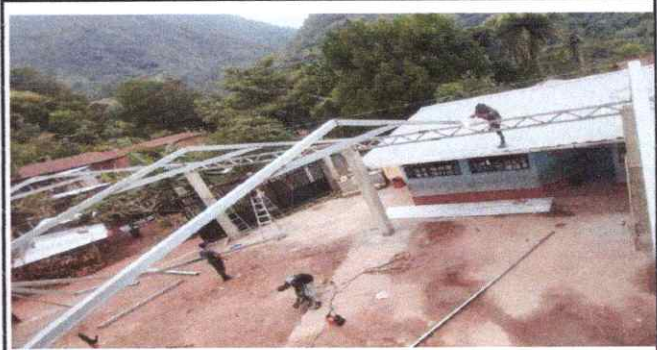
Foto 2: Soldando la estructura que sostendrá el techo
