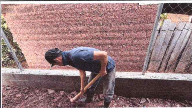
Foto 3: trabajando en el muro perimetral
