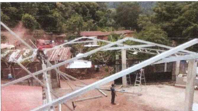
Foto 5: soldando las ultimas piezas de la estructura de soporte
