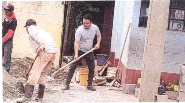
Foto1: Preparando el concreto para el cimiento del muro perimetral
