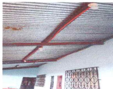
Foto 2: Reparación de luz eléctrica.
