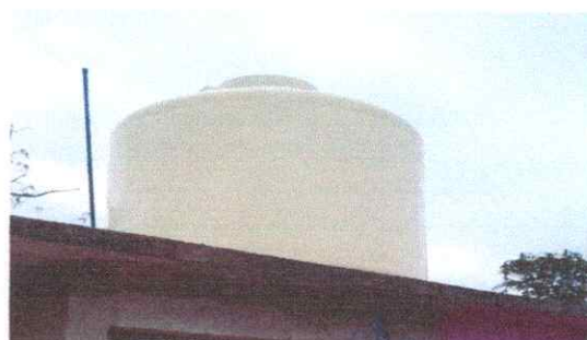
Foto 6: Sustitución de Rotoplast.
