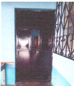
Foto 2: Sustitución de puertas.
