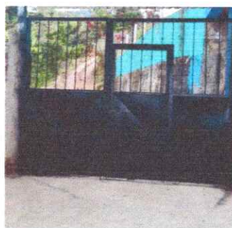
Foto 4: Sustitución de portón.
