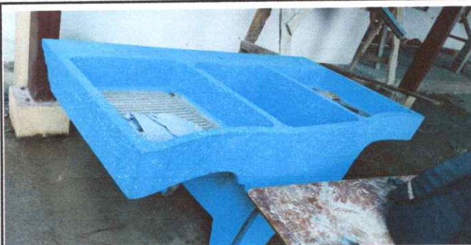
Foto 5: Sustitución de pila de concreto.
