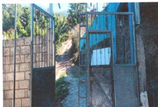
Foto 4: Sustitución de porton.
