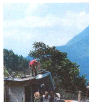
Foto 6: Sustitución de rotoplast.
