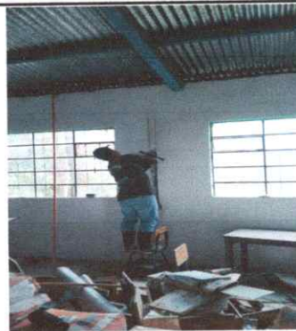
Foto 2: Reparación de luz eléctrica.
