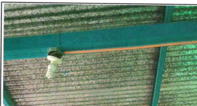
Foto 6: Reparación de sistema eléctrico
