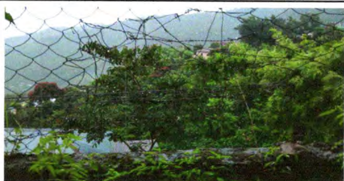
Foto 21: Sustrucción de malla
