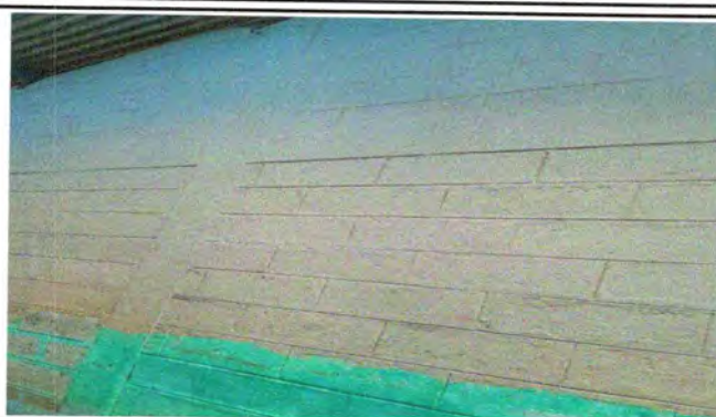
Foto 2: Repello de paredes
