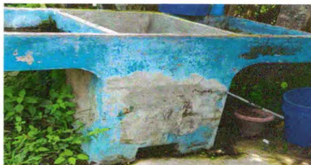
Foto 18: Sustitución de pila de cemento
