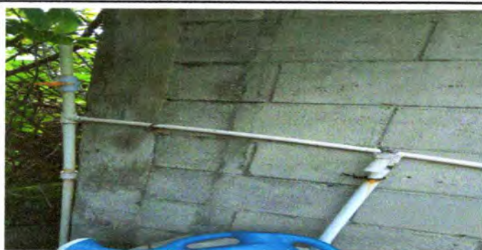
Foto 23: Sustrucción de tubos PVC
