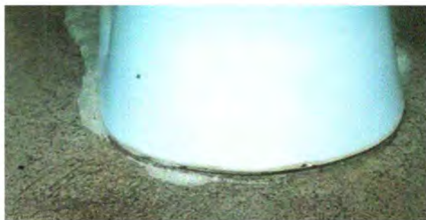
Foto 17: Sustitución de inodoro
