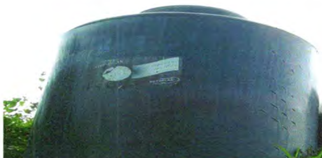
Foto 15: Sustitución de deposito de agua
