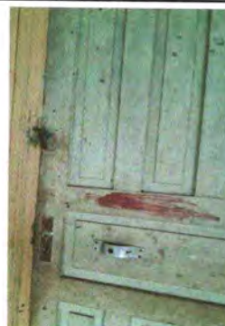
Foto 8: Sustitución de puertas
