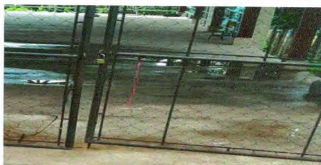
Foto 10: Sustitución de portón.
