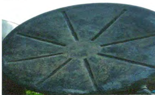
Foto 16: Sustitución de deposito de agua
