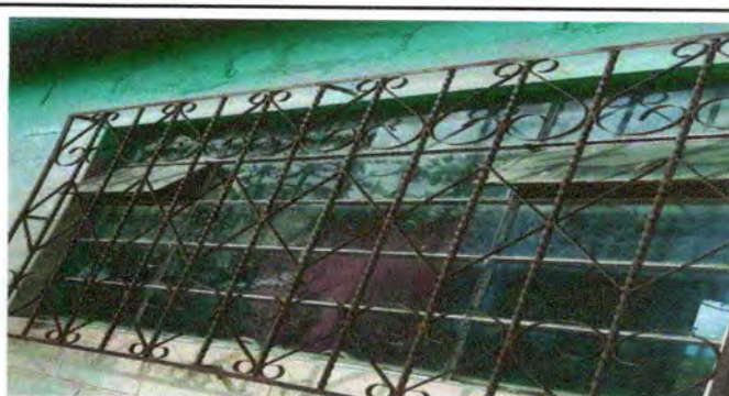
Foto 12: Sustitución de balcones.
