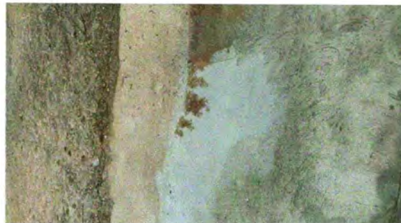
Foto 14: Sustitución de piso granito
