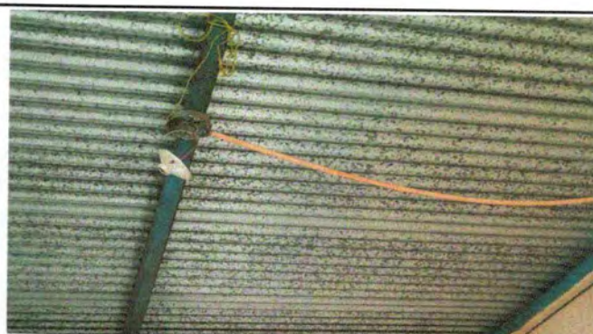
Foto 4: Reparación de sistema eléctrico
