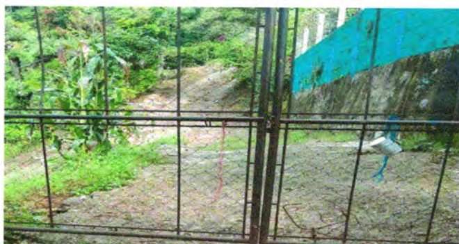
Foto 9: Sustitución de portón.
