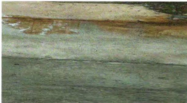
Foto13: Sustitución de piso granito
