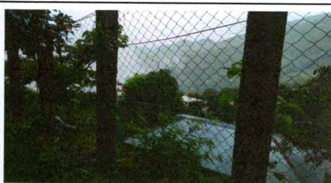
Foto 22: Sustrucción de malla perimetral
