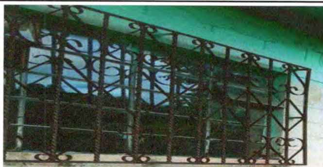
Foto 11: sustitución de balcones.
