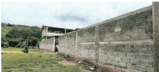
Foto 3: Reparación de muro perimetral de block con tubo hg y malla galvanizada, soleras intermedias y columnas
