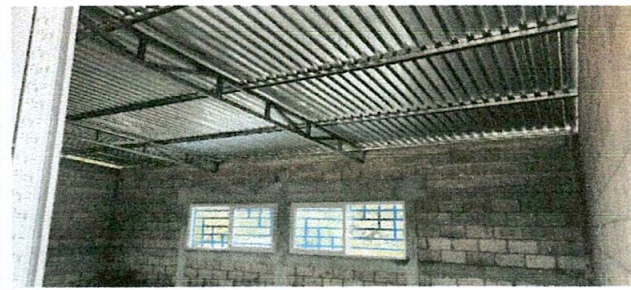
Foto 6: Mejoramiento de estructura de techo
