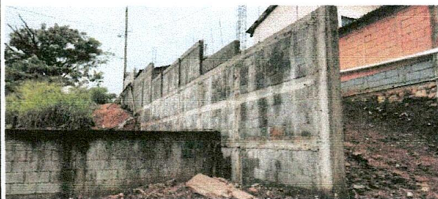
Foto 2: Reparación de muro perimetral de block.
