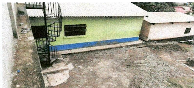
Foto 5: Reparación de banquetas de concreto.
