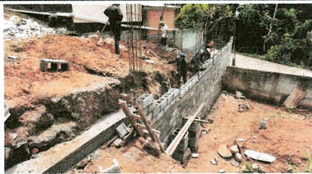
Foto 2: Reparación de muro perimetral de block.
