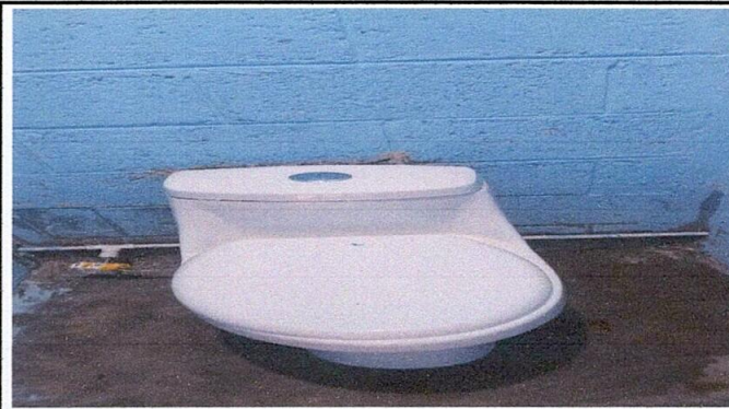
Foto 2: Sustitución de inodoros
