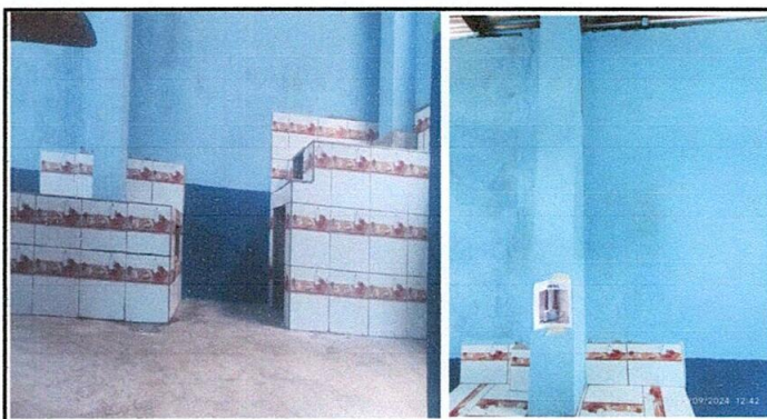
Sustitucion de Plancha de metal y chimenea
