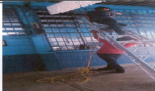
Foto 1: Cambio de balcones
