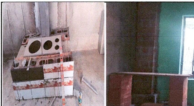
Sustitucion de Plancha de metal y chimenea
