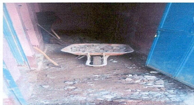
Foto 2: Sustitución de inodoros
