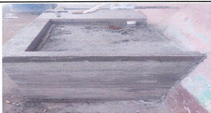
Foto 6: Sustitucion de lavamanos
