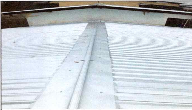
FOTO 4: Mantenimiento de estructuras de techo y capotes
