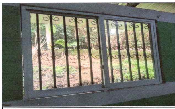
FOTO 5: Sustitución de ventanas de PVC en aulas y ventanas corridizas
