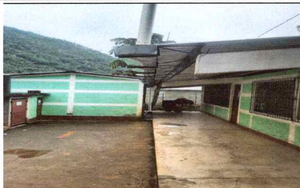
FOTO1: 1.2 Sustitución de sistem de agua pluvial
