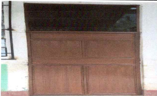
FOTO1: 1.2 Mantenimiento a puertas de metal en aulas, chapas, cambio de tubo
