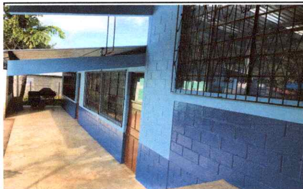
FOTO 3: Pintura general de muros interiores y exteriores
