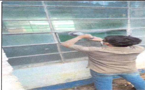
FOTO 7: 4.1 Mantenimietnto de ventanas de metal en aulas
