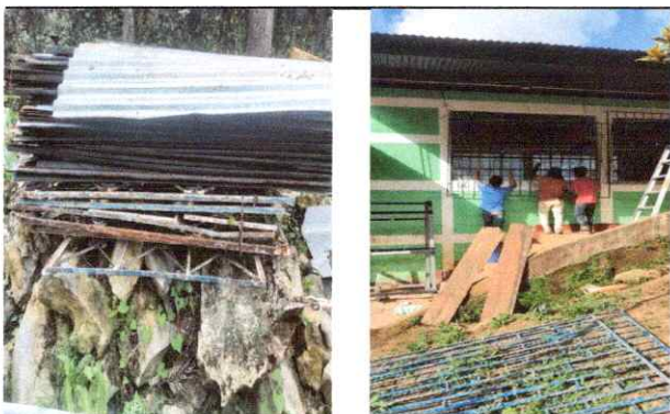
FOTO 9: 5.1 Sustitución de balcones metalicos en aulas
