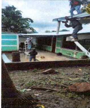
FOTO1: 1.2 Sustitución de sistem de agua pluvial
