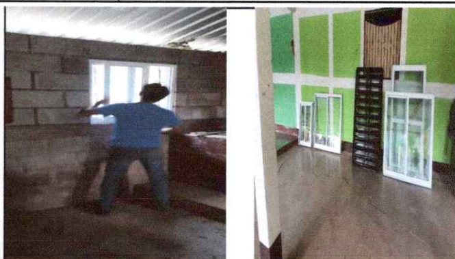
FOTO 8: 4.2 Ventanas corridizas de 3 pulgadas de PVC
