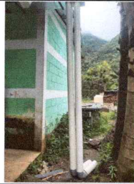
FOTO1: 1.2 Sustitución de sistem de agua pluvial
