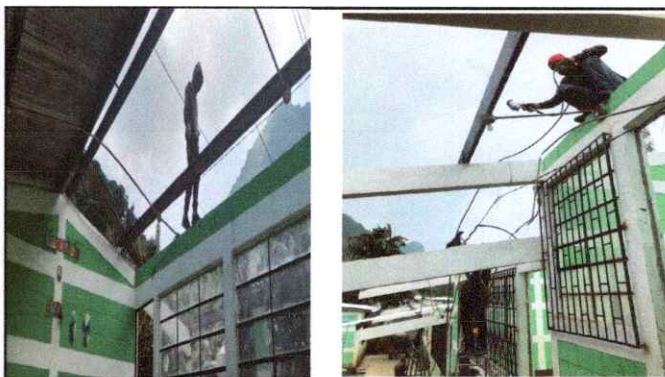
Foto 10: 6.1 Sustitución de lamina troquelada calibre 26 6.2 Capote troquelado y sustitución de elementos de fijación
