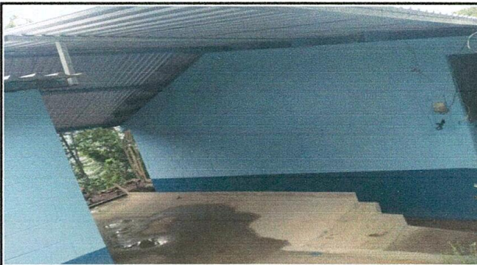
Foto No. 3 Techado frente los baños de la escuela No 2
