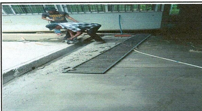
Foto No. 3 Detallando cuneta para ser colocado la parrilla de hierro.
