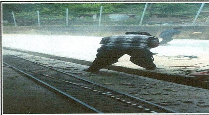
Foto No. 2 detalles de cuneta de concreto frente la escuela No. 2.
