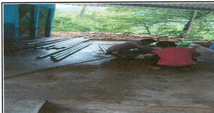
Foto No. 5 Detallando estructura de techo
