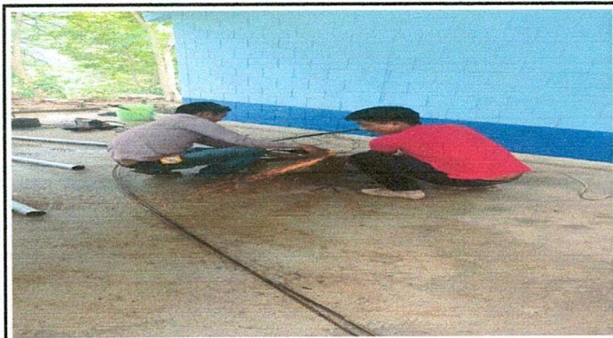
Foto No. 4 herreros trabajando para la estructura del techo.
