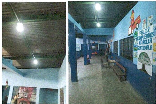
Foto 3: Reparación de Cableado Eléctrico
