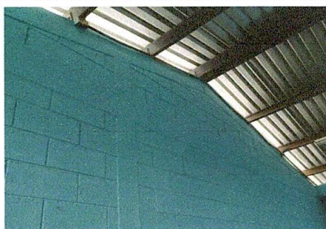
Foto 6: Pinturas de muros exteriores e interiores
