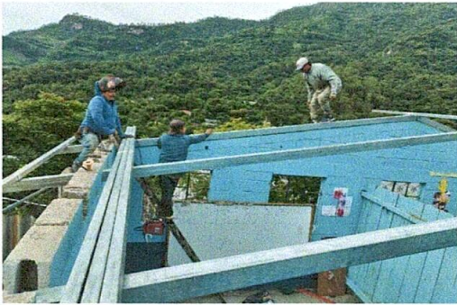
Foto 1: lámina en malas condiciones
