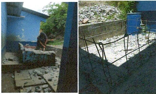
Foto 5: Sustitucion de pila de dos lavaderos
