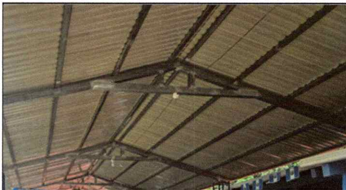
Foto 2: SUSTITUCIÓN DE LÁMINA POR LÁMINA TROQUELADA ALUZINC CALIBRE 26, SUSTITUCIÓN DE ESTRUCTURA DE SOPORTE DE MADERA POR METAL
