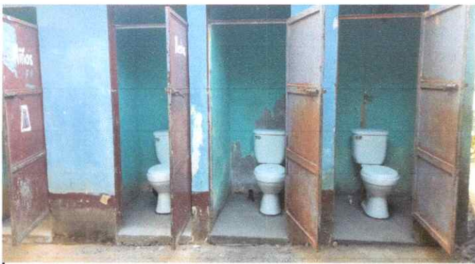
Foto 4: Sustitución de puertas e inodoros + accesorios en servicios sanitarios
