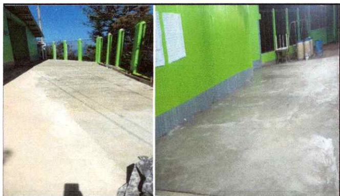
Foto 3: REPARACIÓN DE PISO DE TORTA DE CONCRETO
