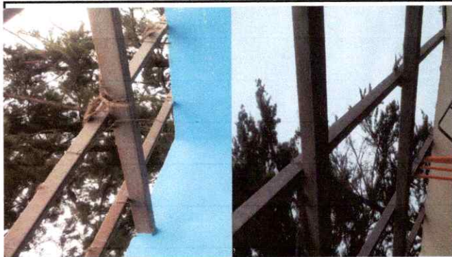
Foto 1: SUSTITUCIÓN DE LÁMINA POR LÁMINA TROQUELADA ALUZINC CALIBRE 26, SUSTITUCIÓN DE ESTRUCTURA DE SOPORTE DE METAL POR METAL Y SUSTITUCIÓN DE PLANCHA DE METAL POR 3 HORNILLAS
