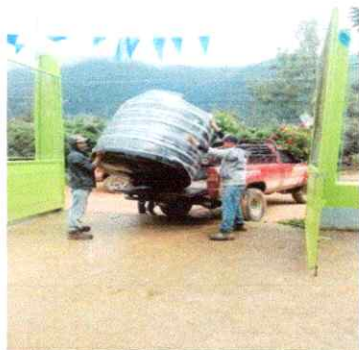
Foto 7: Sustitución y amntenimiento de sisternas/depósitos de agua
