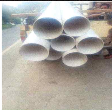
Foto 8: Reparación de drenaje y red de agua potable
