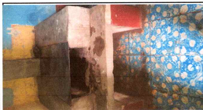
Foto 5: Reparación de cocina
