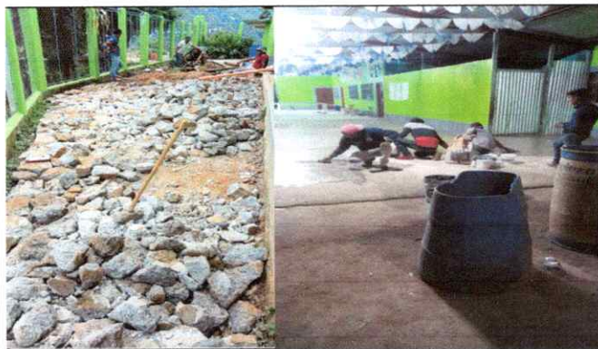
Foto 3: REPARACIÓN DE PISO DE TORTA DE CONCRETO
