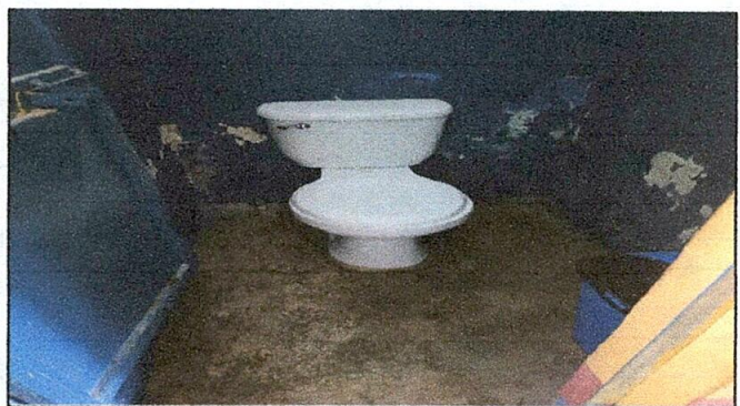
Foto 4. Sustrucción de inodoros
