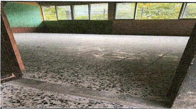
Foto 3. Sustrucción de piso de concreto por piso de granito
