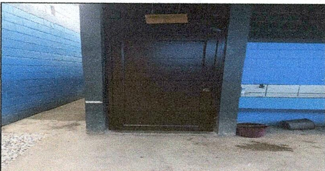
Foto 5. Sustrucción de puerta de metal por puerta de Upvc en color imitación madera
