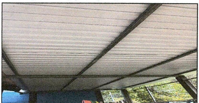
Foto 6. Sustrucción de lámina y madera por lámina troquelada y tubo galvanizado
