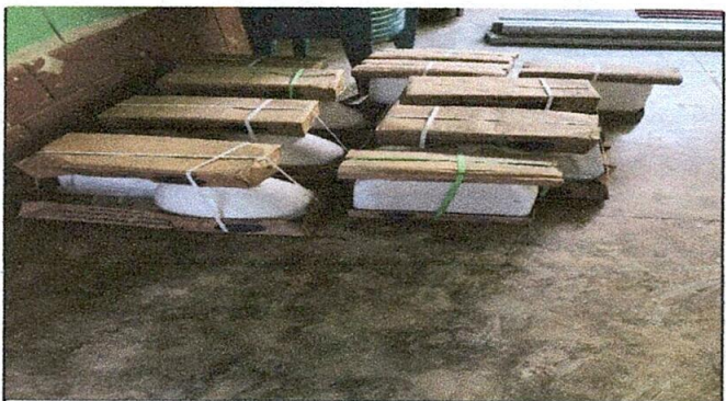
Foto 4: Sustrucción de inodoros
