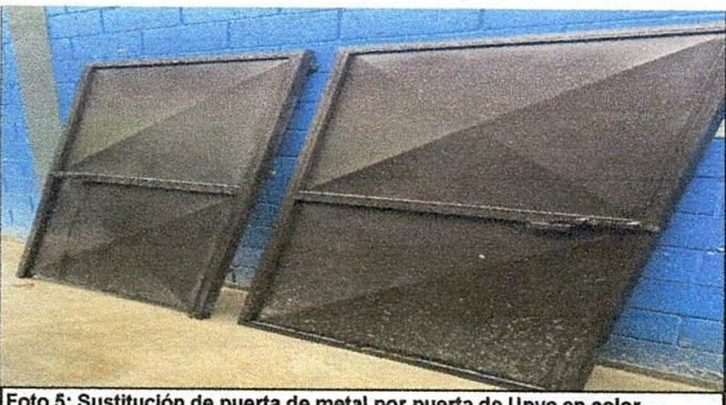
Foto 5: Sustrucción de puerta de metal por puerta de Upvc en color imitación madera
