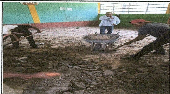
Foto 2: Sustrucción de piso de concreto por piso de granito
