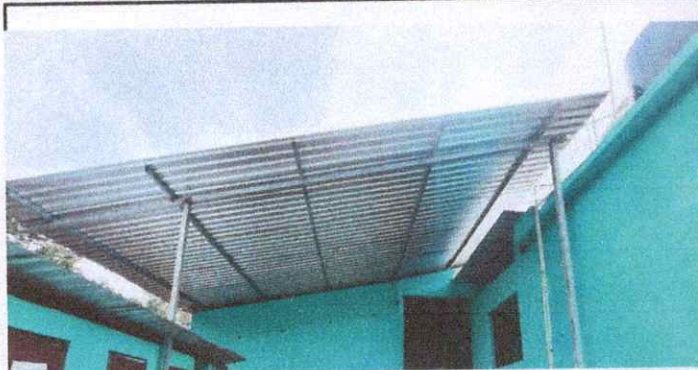
Foto 1: Sustrucción de estructura de techo
