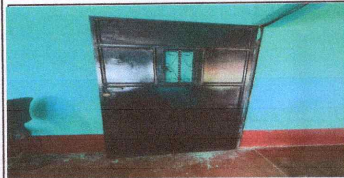
Foto 5: Mantenimiento de puertas
