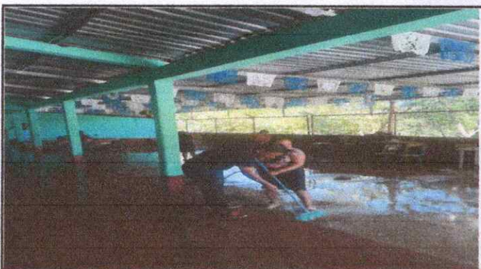
Foto 3: Sustitución de piso
