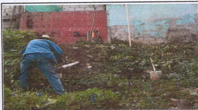
Foto 4: Sustrucción de tubería pvc
