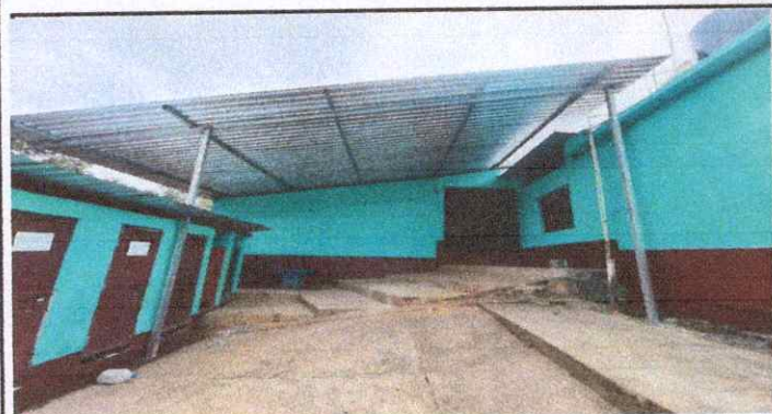
Foto 3: Sustrucción de estructura de soporte de techo
