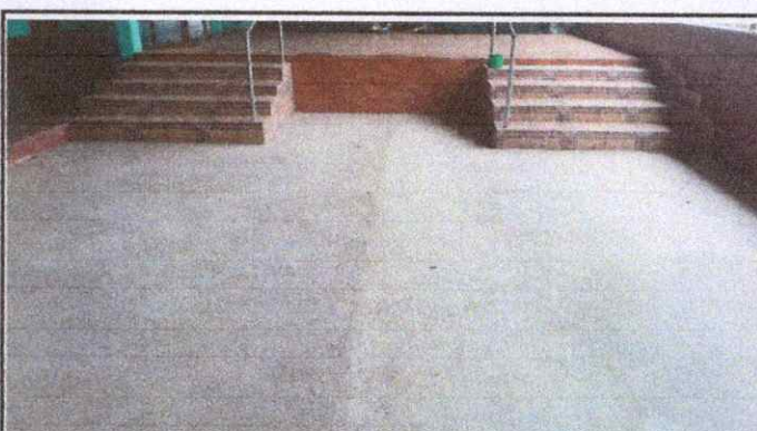
Foto 4: Sustitucion de piso
