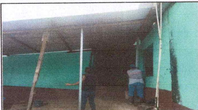
Foto 3: Sustitución de estructura de soporte de techo
