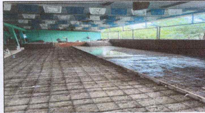
Foto 4: fundicion de piso
