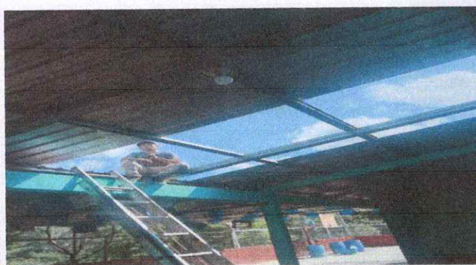
Foto 5: Sustitución de techo
