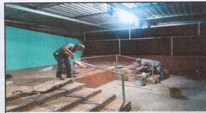
Foto 6: Sustitución de gradas
