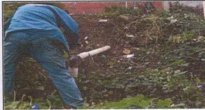
Foto 4: Sustitución de tubería pvc
