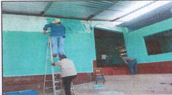
Foto 2: Pintura en muros exteriores e interiores
