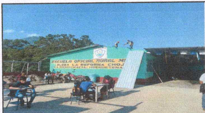
Foto1: Sustitución de techo
