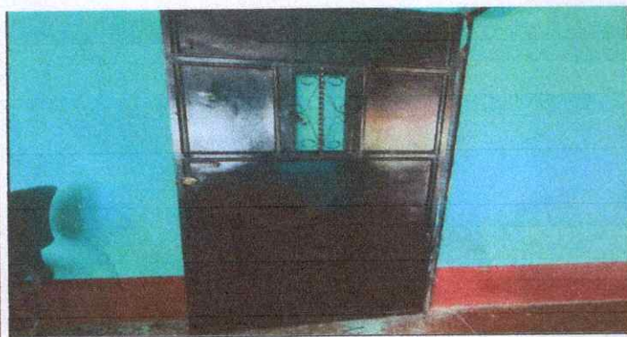
Foto 5: Sustitución de puertas
