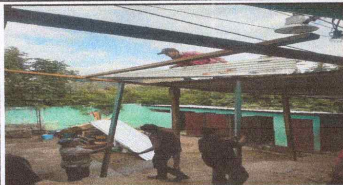
Foto 1: Sustitución de estructura de techo
