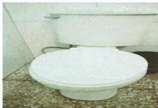
SUSTITUCIÓN DE BAÑOS
