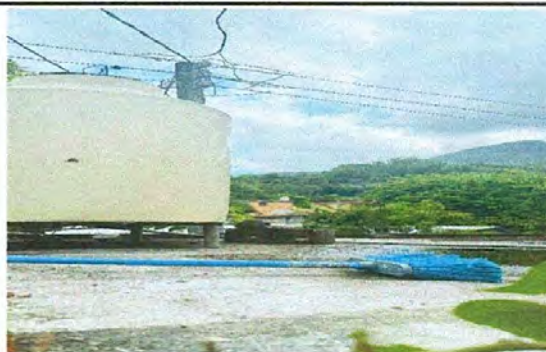
SUSTITUCIÓN DE DEPÓSITO DE AGUA
