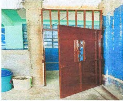
SUSTITUCION DE PUERTAS
