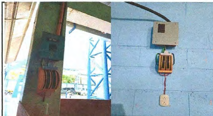
SUSTITUCION DE CABLEADO DE ENERGÍA ELECTRICA
