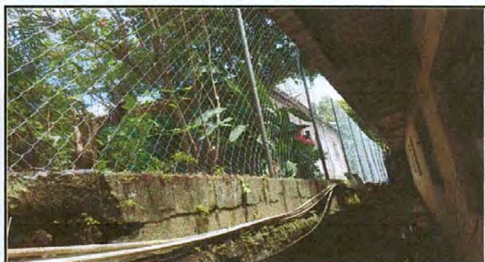
SUSTITUCIÓN DE MALLA
