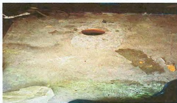
MEJORAMIENTO DE SISTERNA
