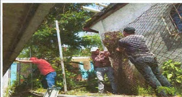
SUSTITUCIÓN DE MALLA
