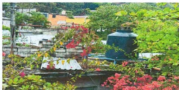
SUSTITUCIÓN DE TINACO
