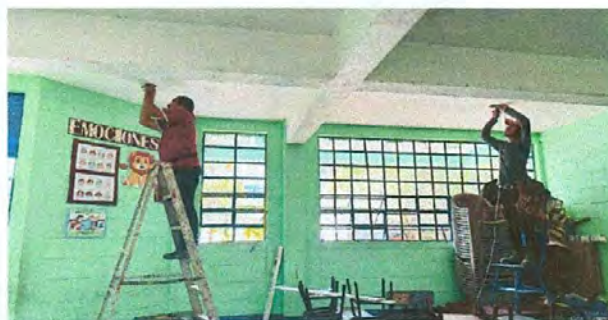
MEJORAMIENTO DE CABLEADO ELÉCTRICO
