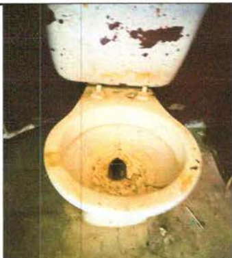
Foto 1: Sustrucción de inodoros
