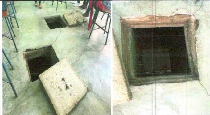
Foto 8: Reparación de cisterna de concreto
