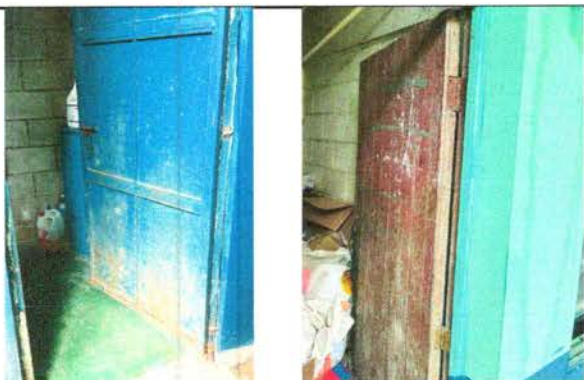
Foto 3: Sustrucción de puertas
