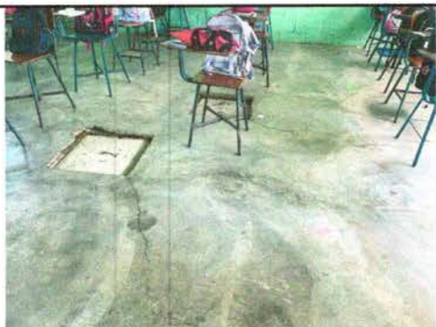
Foto 5: Sustrucción de piso de cemento líquido por piso cerámico
