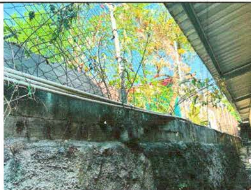
Foto 2: Reparación de tubo hg y malla galvanizada
