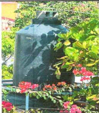
Foto 7: Sustitución de depósito de agua 1100 lt
