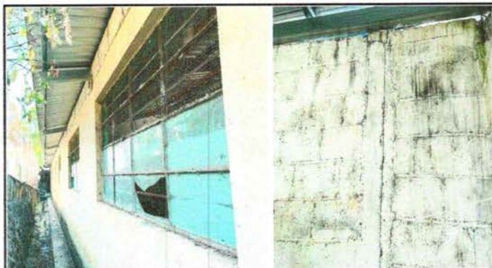
Foto 9: Pintura en muros exteriores e interiores
