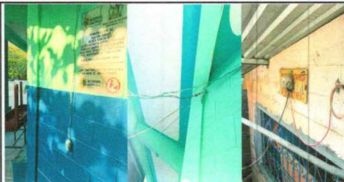
Foto 6: Reparación de cableado eléctrico
