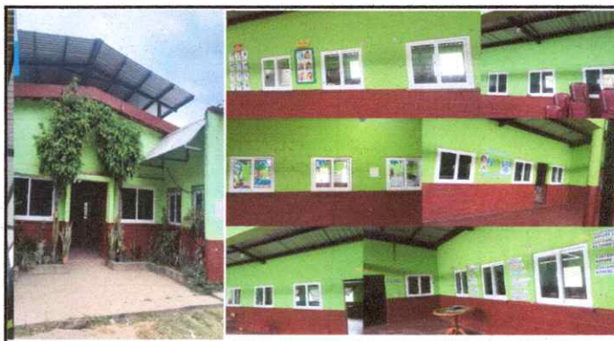
Foto 4: CAMBIO DE VENTADAS PVC PARTE DE AFUERA Y ADENTRO
