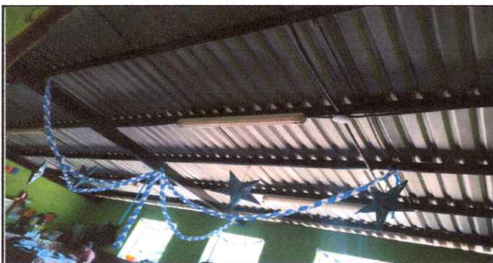
Foto 5: CAMBIO DE LÁMPARAS POR FOCOS AHORRADORES, CABLEADO
