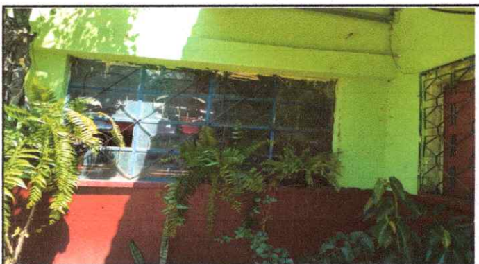
Foto 3: CAMBIO DE VENTADAS PVC PARTE DE AFUERA Y DE ADENTRO
