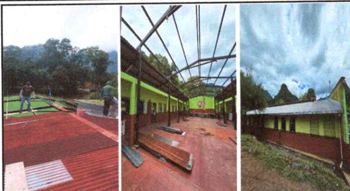
Foto 2: CAMBIO DE LÁMINA TROQUELADA TECHO DE LÁMINAS DEL SALON DEL CENTRO OXIDADA
