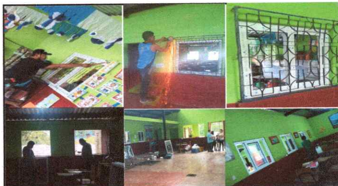
Foto 4: CAMBIO DE VENTADAS PVC PARTE DE AFUERA Y ADETRON
