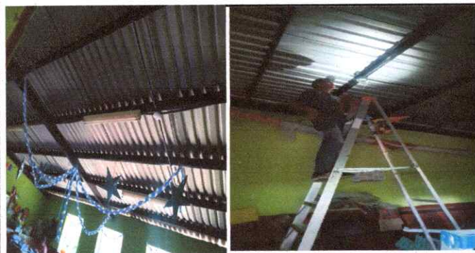
Foto 5: CAMBIO DE LÁMPARAS POR FOCOS AHORRADORES, CABLEADO
