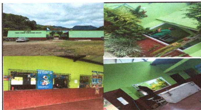
Foto 3: CAMBIO DE VENTADAS PVC PARTE DE AFUERA Y DE ADETRON
