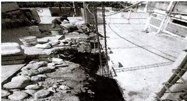
Foto 1: Destrucción del muro perimetral antiguo y comienzo de los trabajos del nuevo muro perimetral.
