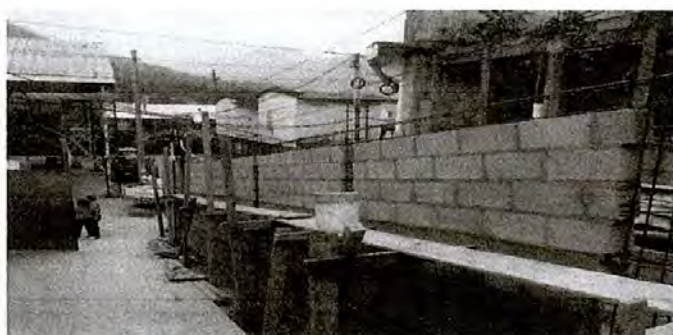
Foto 3: Leantamiento de la pared del muro perimetral 15 metros de largo.
