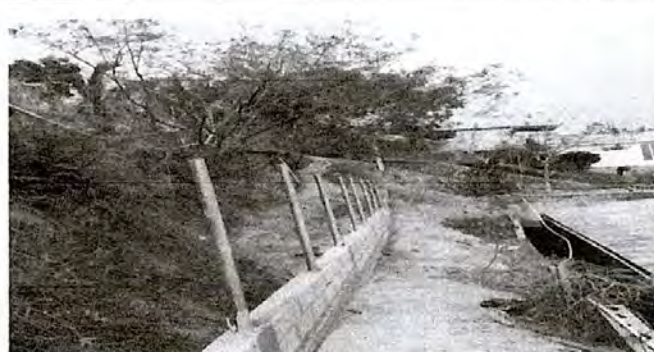
Foto 2: Continuidad de la fundición de columnas con tubos galvanizados para colocación de malla
