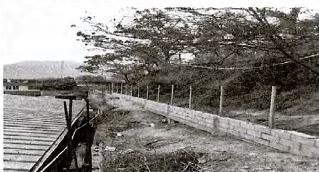
Foto 1: Fundición de columnas con tubos galvanizados para colocación de malla
