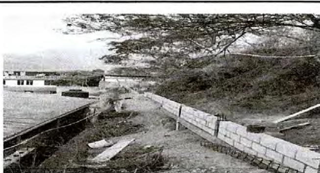
Foto 6: Colocación de blocks y preparación de fundición de columnas y tubos galvanizados para colocación de malla.
