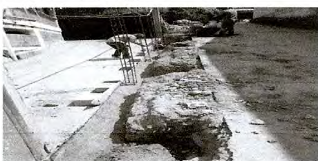
Foto 2: Fundición de la primer solera del muro perimetral
