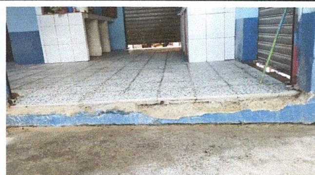
Foto 6: PISO: Sustitución piso de granito
