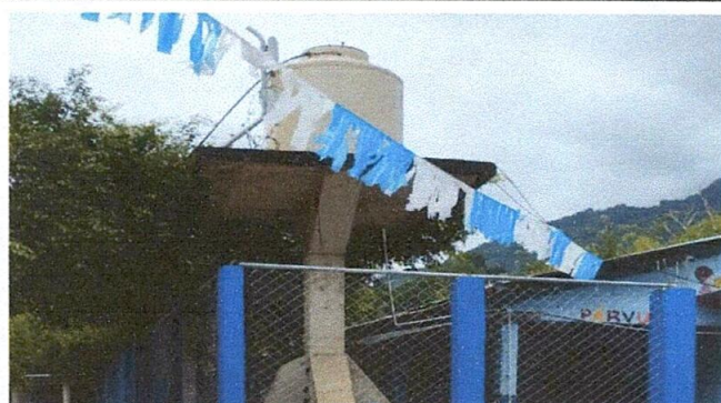
Foto 3: RED DE AGUA POTABLE: sustitución de depósitos de agua de 400 lt. por uno de 1,100 lt.
