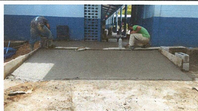
Foto 4: LOSA DE PATIO: Sustitución de planchas de concreto
