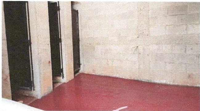
Foto 1: PUERTAS DE METAL Puertas de servicio sanitario sustituidas.
