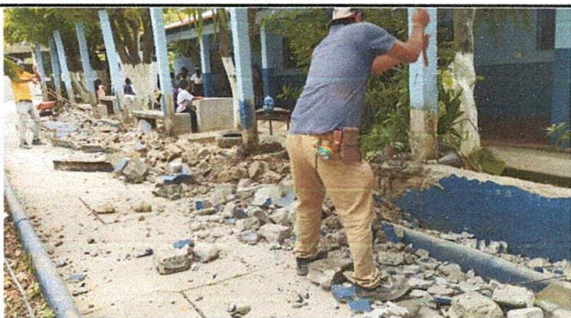
Foto 5: MURO PERIMETRAL: Demolición de muro perimetral.
