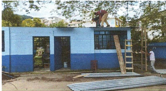
Foto 2: CUBIERTA DE LÁMINA. Desmontando la lámina vieja.
