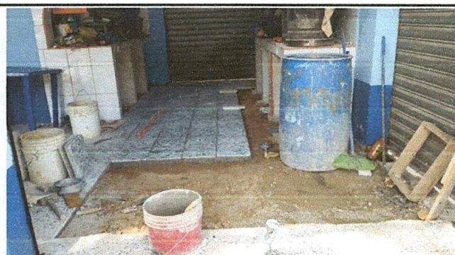
Foto 6: PISO: Sustitución piso de granito
