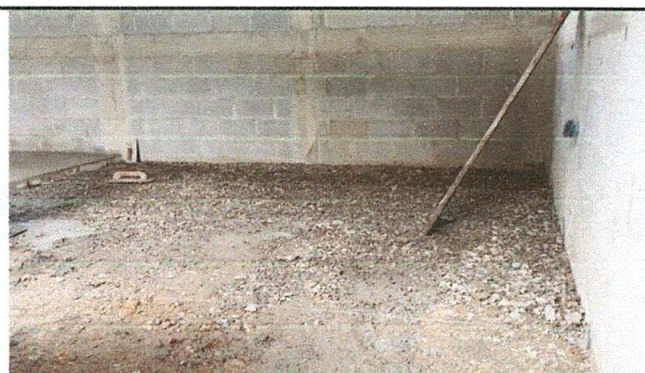
Foto 3: PISO DE CEMENTO LÍQUIDO:
