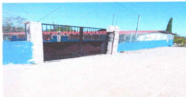
Foto 2: finalización de mantenimiento a portones de metal
