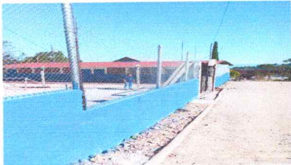
Foto1: finalización Sustrucción de bajada de agua pluvial de metal por tubo pvc
