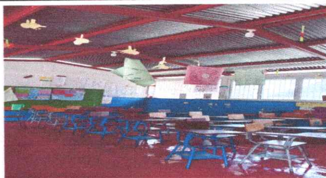
Foto 4: finalización de Reparación de lamparas
