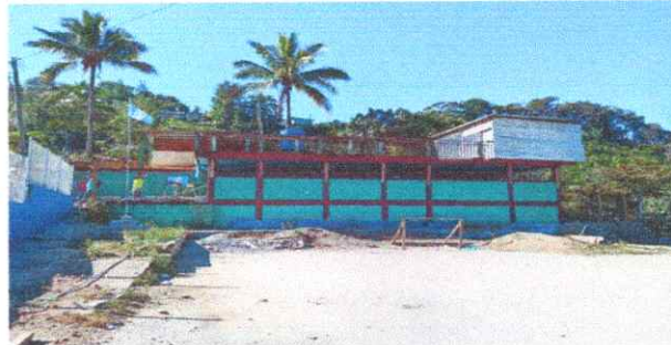
Foto 6: finalización de reparación de muro perimetral
