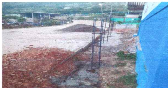
Foto 6: durante de trabajo del muro perimetral
