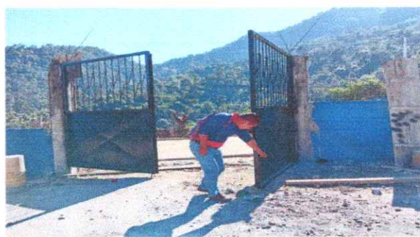
Foto 2: durante de instalacion del portones de metal
