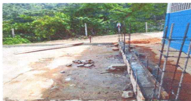
Foto4: durante del traajo del muro perimetral
