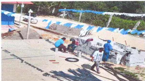
Foto1: Durante del trabajo del muro perimetral
