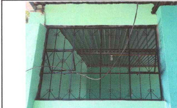
Foto 2: Sustitución de estructura de metal de ventana
