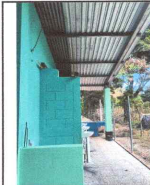
Foto 1: Sustitución de lamina de los baños, puertas y estructura de techo de baño para que no afecte en tiempo de lluvia. Puertas de Metal
