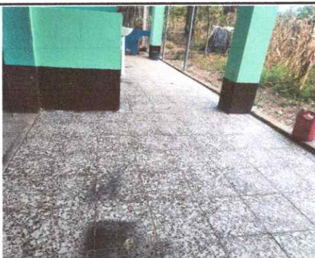
Foto 3: Reparación de piso de granito
