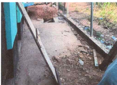
Foto 3: Reparación de piso de granito
