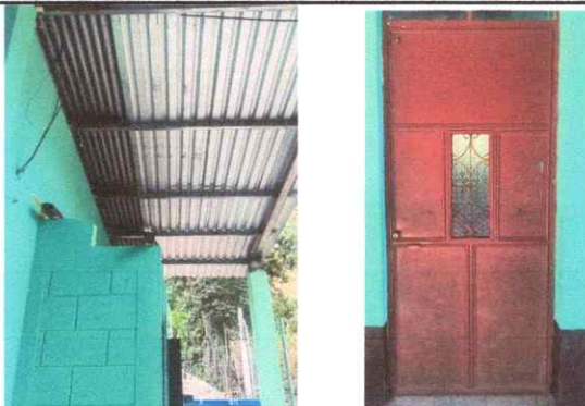
Foto 1: Sustrucción de lamina de los baños, puertas y estructura de techo de baño para que no afecte en tiempo de lluvia. Puertas de Metal
