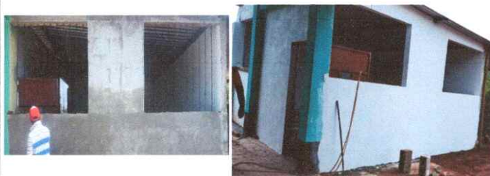
Foto 5: Reparación de Repello Y Cernido de Paredes
