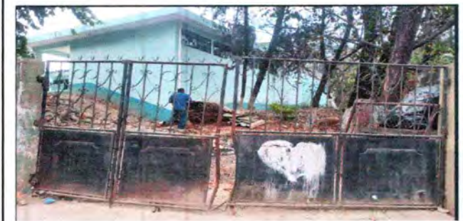
Reparación de portón
