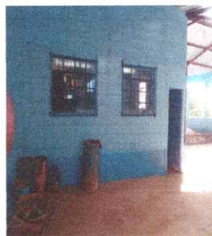
VENTANAS (vidrios y balcones)
