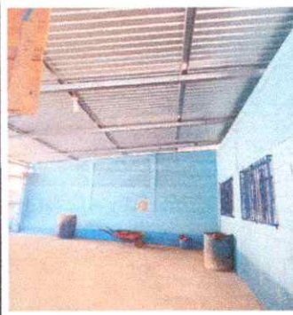
ESTRUCTURA DE TECHO
