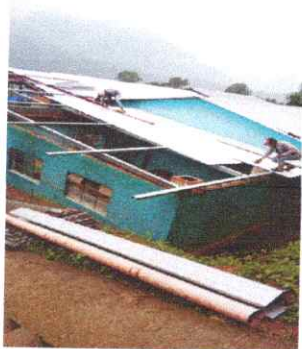
CUBIERTA DE LAMINA
