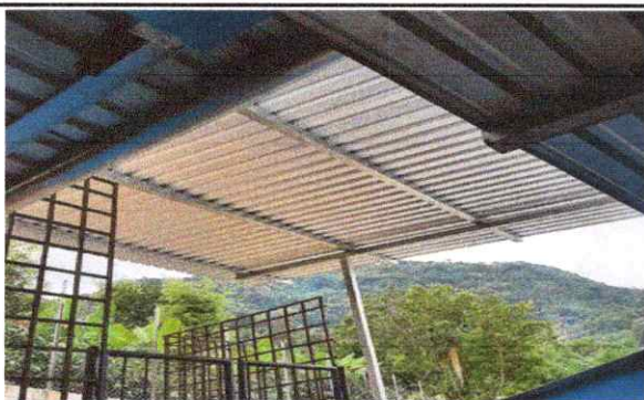
Foto 5: Sustitución de lámina a lámina troquelada
