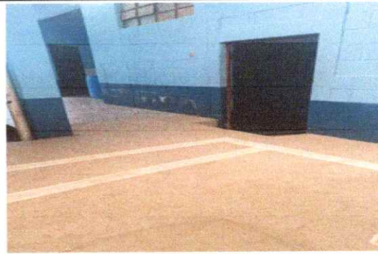
Foto 6: Sustitución de piso de torta de concreto
