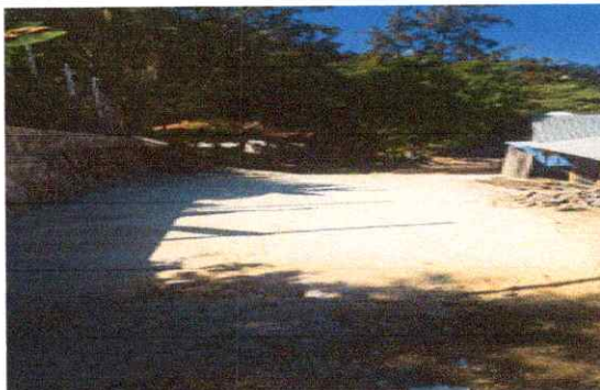
Foto 4: Sustitución de piso de torta de concreto
