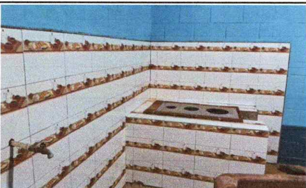
Foto 3: Sustitución de plancha de metal tres hornillas
