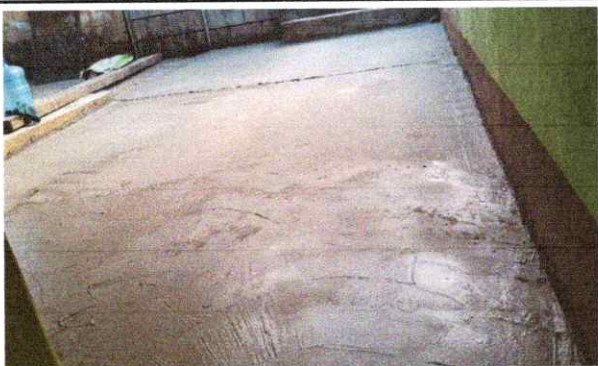
Foto 3: Sustitución de piso de torta de concreto
