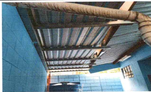
Foto 2: Sustitución de lámina por lámina troquelada
