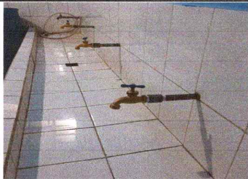
Foto1: Sustitución de llaves de chorros
