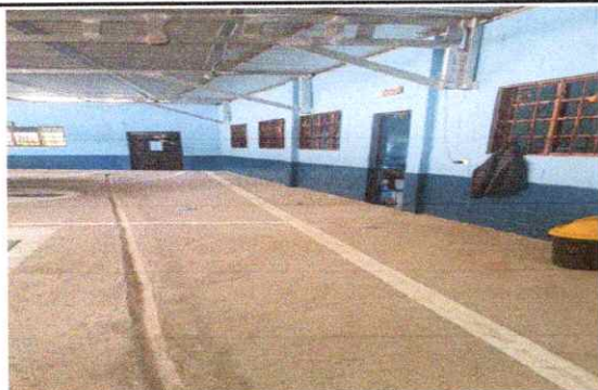
Foto 5: Sustitución de piso de torta de concreto
