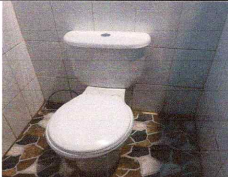
Foto 2: Sustitución de inodoro
