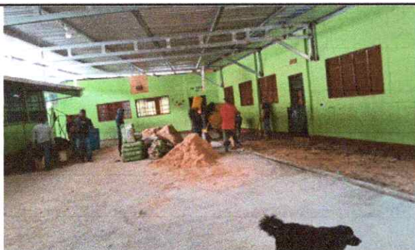
Foto 5: Sustitución de piso de torta de concreto
