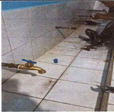
Foto1: Sustrituición de llaves de chorros
