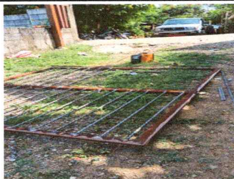
Foto 4: Mantenimiento a portones de metal
