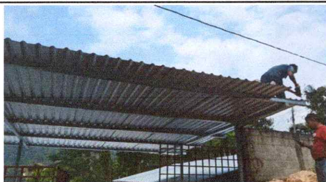
Foto 5: Sustitución de lámina a lámina troquelada
