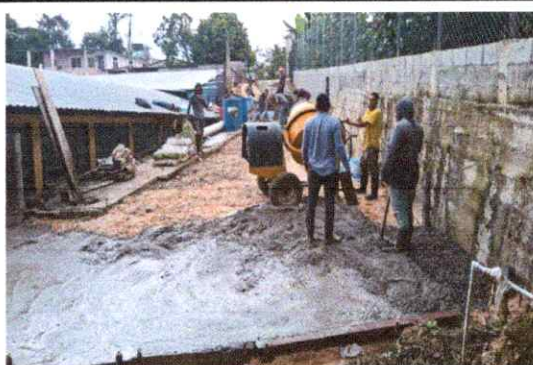
Foto 4: Sustitución de piso de torta de concreto
