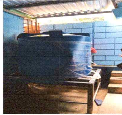
Foto 2: Sustrituición de depósitos de agua 1700 Lt
