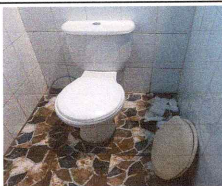
Foto 2: Sustitución de inodoro
