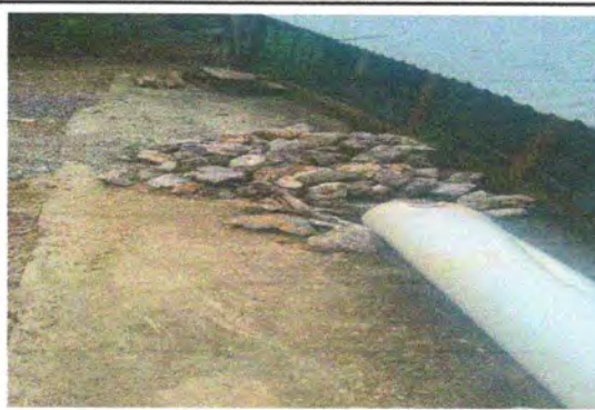
Foto 4: Sustitución de piso de torta de concreto
