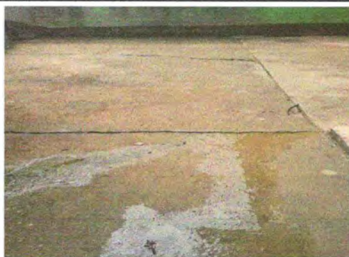
Foto 3: Sustitución de piso de torta de concreto
