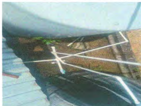
Foto 2: Sustrucción de depósito de agua 1700 Lt
