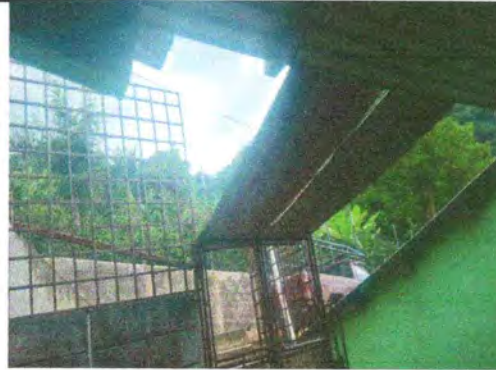
Foto 2: Sustitución de lámina por lámina troquelada
