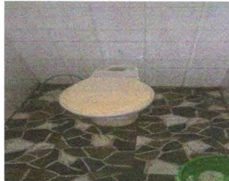
Foto 2: Sustitución de inodoro
