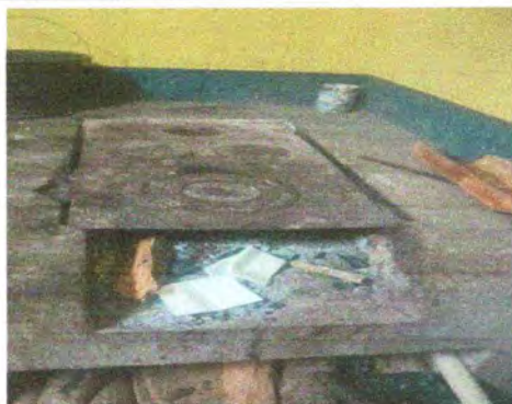
Foto 3: Sustitución de plancha de metal tres hornillas
