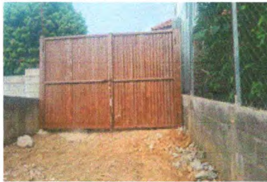
Foto 4: Mantenimiento a portones de metal
