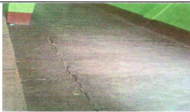
Foto 5: Sustitución de piso de torta de concreto
