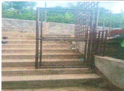
Foto 1: Mantenimientos de portones de metal
