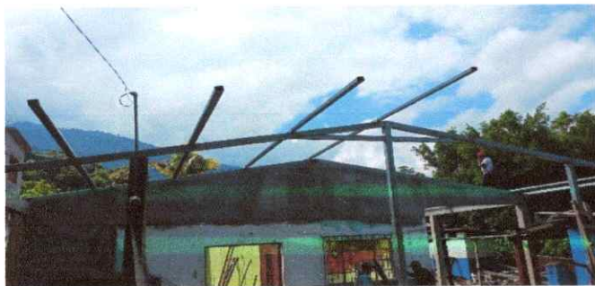
Foto1: COLOCACIÓN DE ESTRUCTURA METALICA
