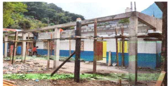
Foto 6: avansando en el techo y piso
