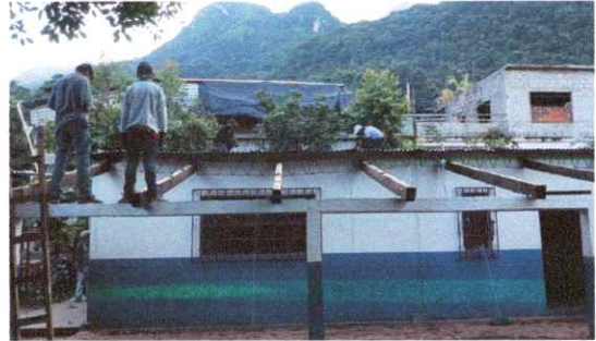
Foto 2: Cambio y levantamiento de techo
