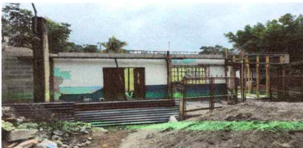
Foto 5: Reparación de portón
