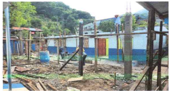
Foto 4: Reparación de piso por piso de granito
