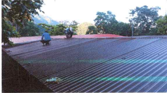
Foto1: cambio de techo
