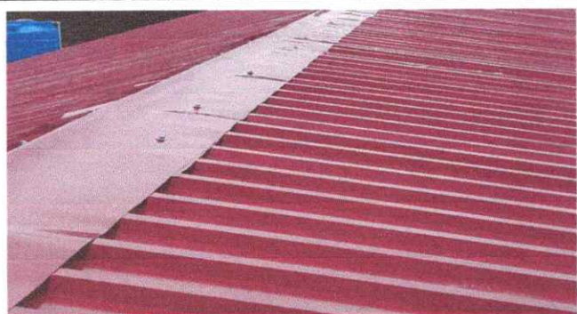
Foto 5: Sustitución de lámina
