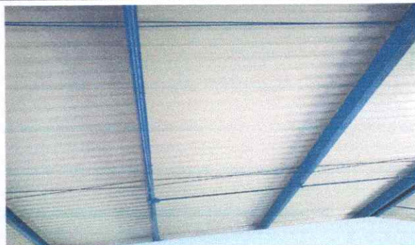
Foto 2: Sustitución de estructura de soporte de metal
