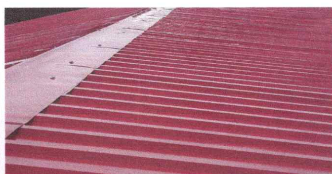
Foto 6: Sustitución de lámina
