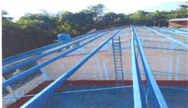
Foto1: Sustitución de estructura de soporte de metal
