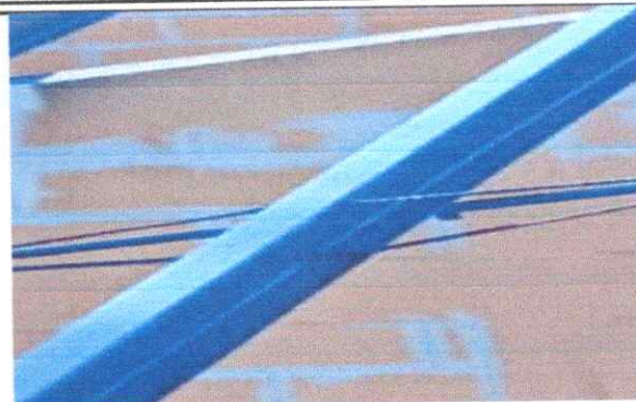
Foto 2: Sustitución de estructura de soporte de metal
