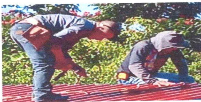
Foto 5: Sustitución de lámina
