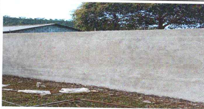
Foto 12. Repello en muros perimetrales
