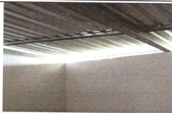
Foto 2: Cambio de soporte de madera por estructura de metal
