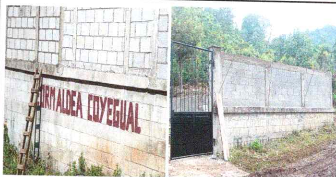
Foto8: Sustitución de malla de metal por block en muros perimetrales
