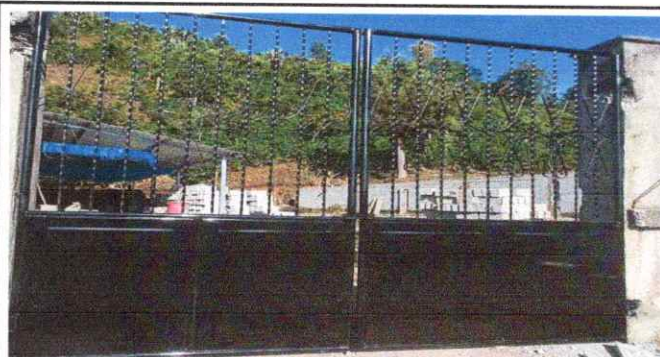
Foto 6: Sustitución de portón de malla por porton de metal
