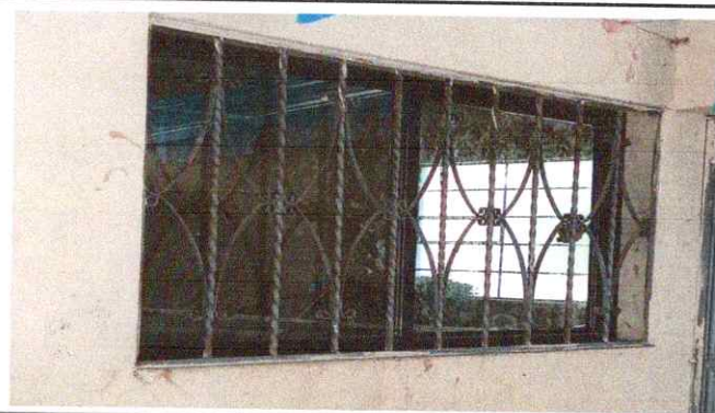
Foto 11. Instalación de ventanas en aulas
