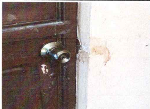
Foto 5: Sustitución de chapas en los baños
