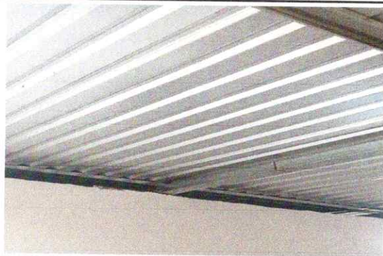
Foto1: Cambio de la cubierta de lámina
