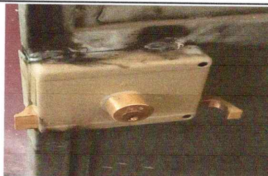
Foto 4: Sustitución de Chapas de las aulas
