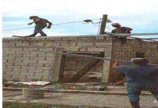
Foto 2: Cambio de soporte de madera por estructura de metal
