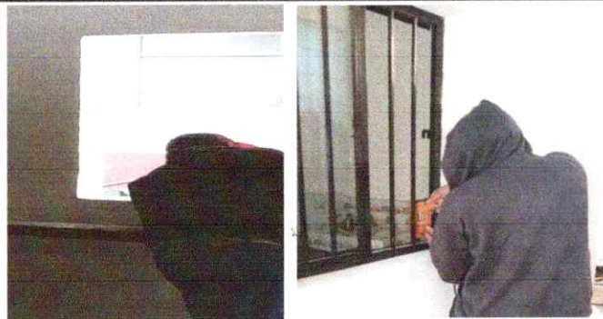
Foto 7: Instalación de una ventana en la cocina
