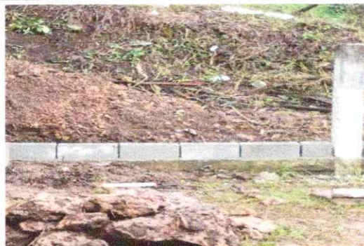
Foto8: Sustitución de malla de metal por block en muros perimetrales
