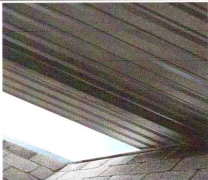
Foto1: Cambio de la cubierta de lámina
