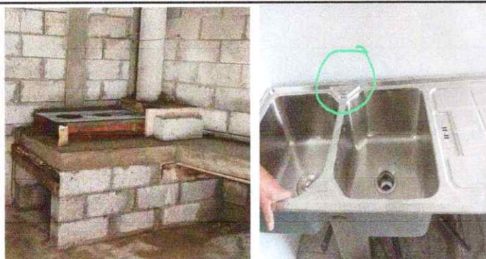
Foto 9: Reparación de cocina: instalación de estufa rural y lavatrastos
