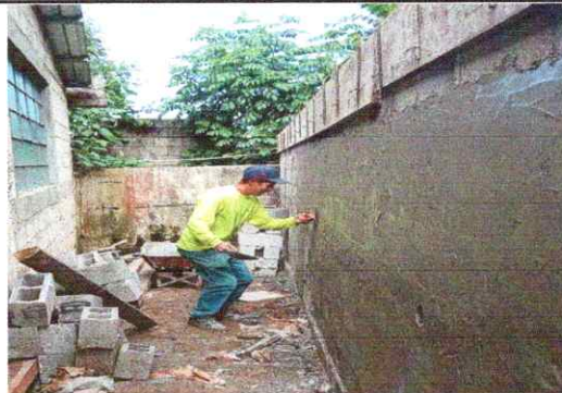
12. Repello en muros perimetrales
