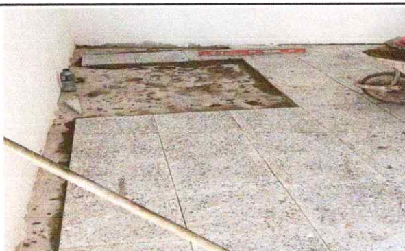
Foto 3: Sustitución de piso de torta de concreto por piso de granito
