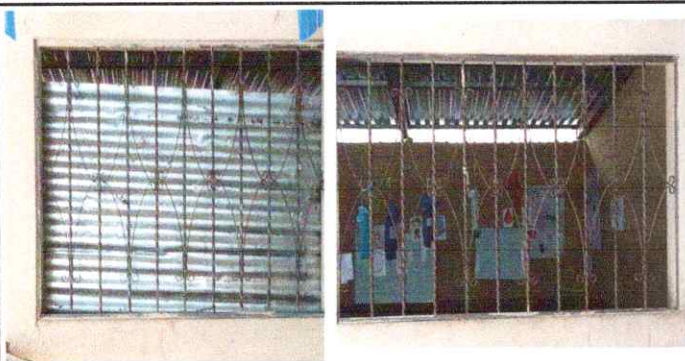
Foto 11. Instalación de ventanas en aulas
