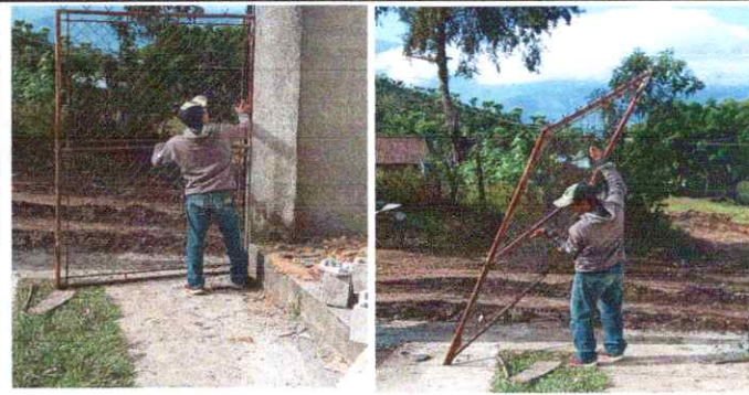
Foto 6: Sustitución de portón de malla por porton de metal
