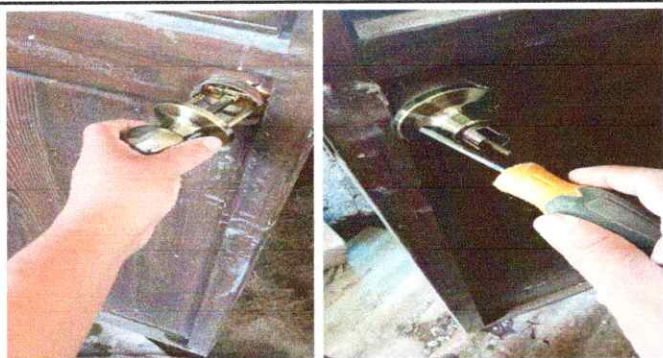
Foto 5: Sustitución de chapas en los baños
