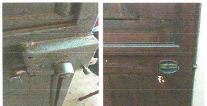
Foto 4: Sustitución de Chapas
