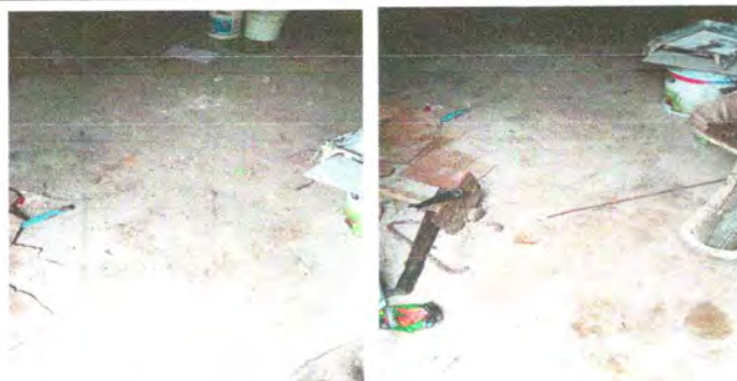
Foto 3: Piso, torta de cemento
