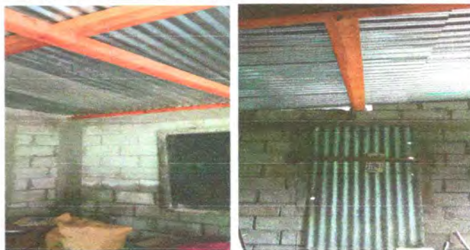
Foto 2: Estructura de techo
