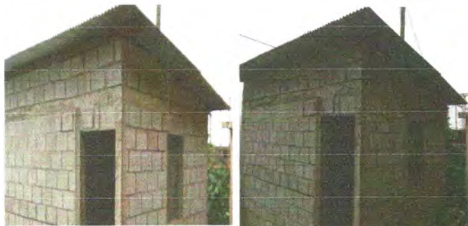
Foto1: Cubierta de lámina
