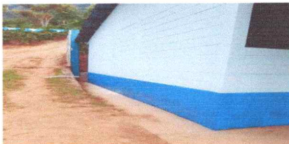
Foto 5: Aplicación de pintura
