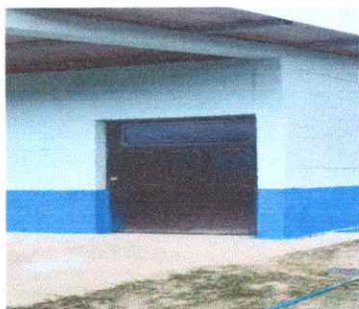
Foto 3: colocacion de puertas
