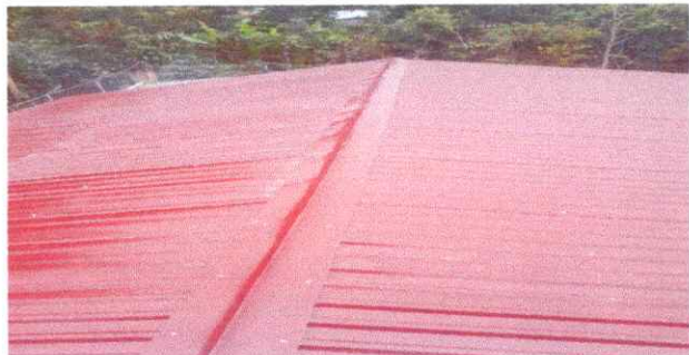
Foto1: Sustitución de lámina por lámina troquelada
