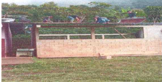
Foto1: Sustitución de lámina por lámina troquelada
