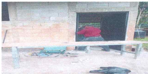
Foto 3: colocacion de puertas
