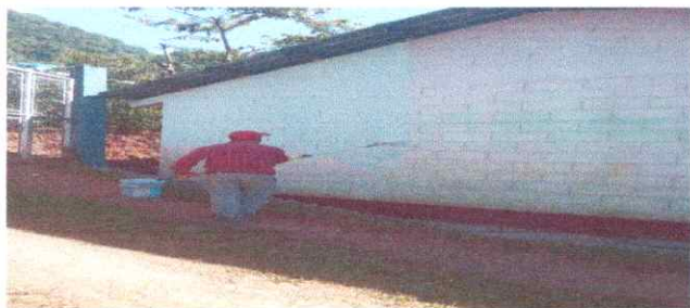
Foto 5: Aplicación de pintura
