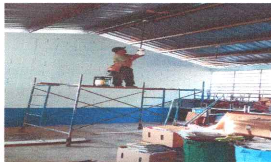
Foto 4: Reparación de sistema eléctrico y sustitución de focos
