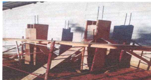
Foto 6: Sustitución de tinaco
