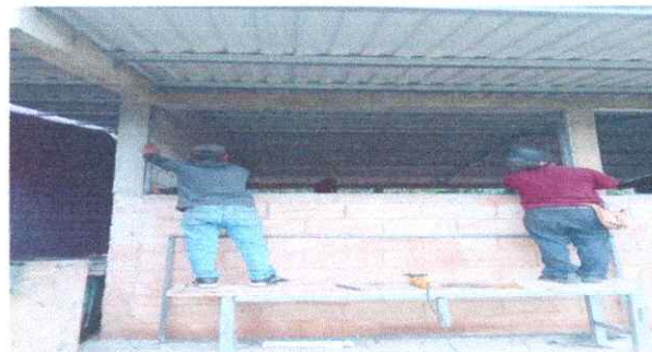
Foto 2: Sustitución de balcones, estructura de ventanas, vidrio, balcones
