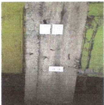
Foto 5: Terminación de arreglo de energía eléctrica
