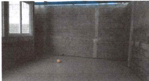
Foto 2: Terminación de una aula
