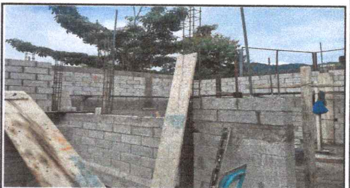
Foto 4: Reparación de paredes
