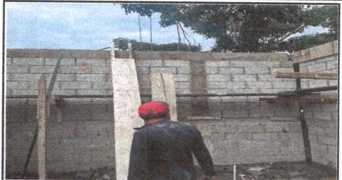
Foto 2: Reparación de paredes
