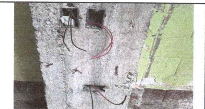
Foto 5: Reparación de electricidad
