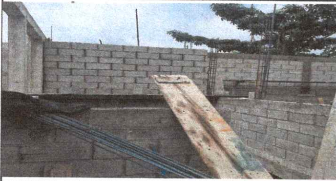
Foto1: Reparación de paredes
